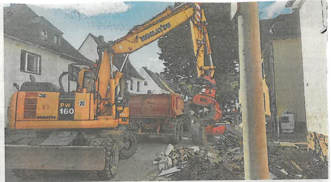
Noch immer werden Schutt und Schlamm aus den Gebäuden im Ahrtal abtransportiert. In den gesäuberten Häusern wollen jetzt Handwerker aus dem Emsland die Heizungs- und Sanitärbereiche sanieren.
