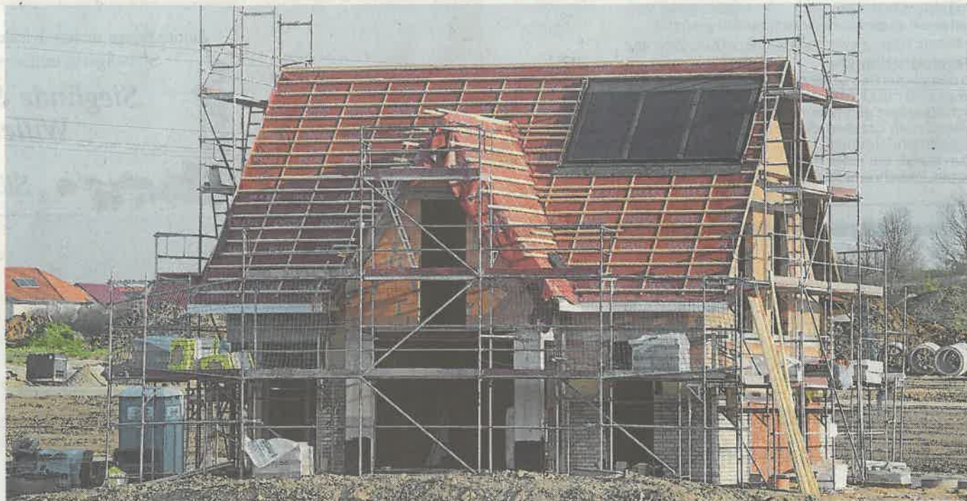
Weil Baustoffe nach wie vor fehlen, droht auf manchen Baustellen Stillstand.
